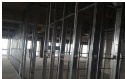
轻钢龙骨石膏板隔墙
