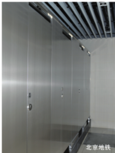
纯304不锈钢整体隔断安装实景
