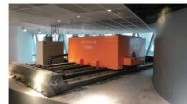
直线电机驱动的AMD系统
