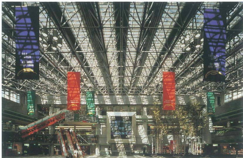
■新千歳空港旅客ターミナルビル SL80外側し、SLB05突き上げ、SLE80突き上げ
