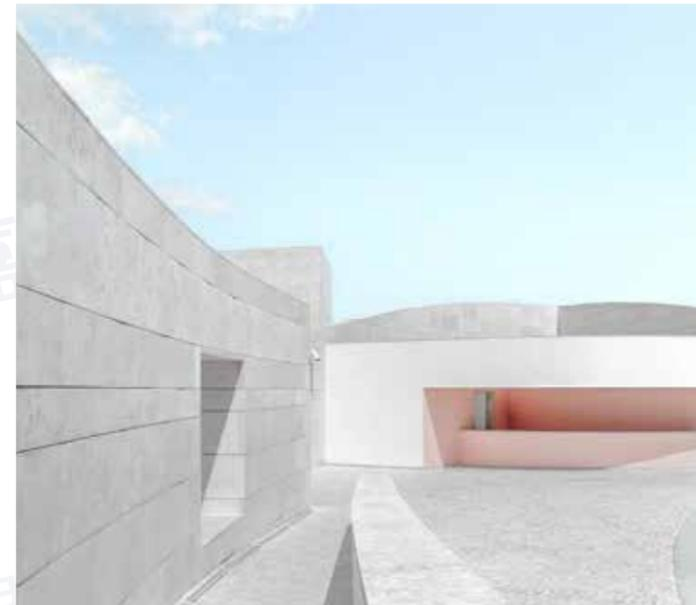
在清水混凝土表面涂装水性混凝土保护专用底漆，能有效地防止墙体出现润湿痕迹，并在内部形成吸水防止层，避免水泥发生中性老化。防水层还具有出色的防盐害功能，可以有效防止内部钢筋被腐蚀，同时抑制混凝土表面吸收不均匀，防止出现光泽不均匀及墙体润湿痕迹等现象。该产品需与混凝土保护剂配套使用。
