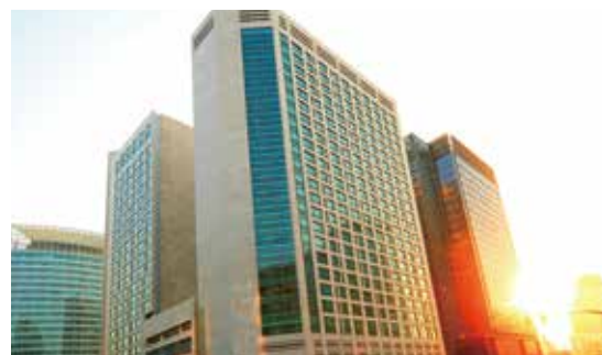
金融街(亚投行总部办公楼)
