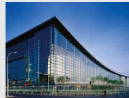
国家奥林匹克新闻中心 National Olympic Press Center, China 位置：中国●北京 Location: Beijing (P.R. China)
