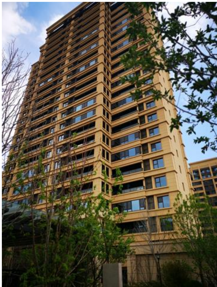
项目名称：金茂中欧国际智慧新城 产品工艺：真石漆+质感+荔枝面多彩+A级板 施工时间：2017-2019年
