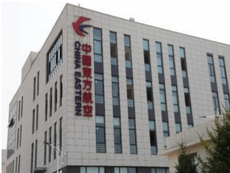
中国东方航空机务维修区项目
