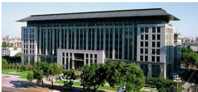
中组部办公楼
