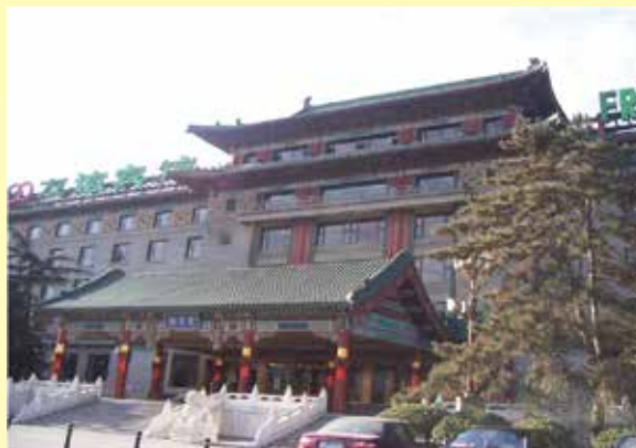
工程名称: 友谊宾馆外国专家服务楼 工程地点: 中关村南大街 建设单位: 友谊宾馆 总包单位: 承德华宇建筑公司 防水范围: 地下室、屋面、游泳池防水 防水面积: 1.7 万 \text{m}^2
