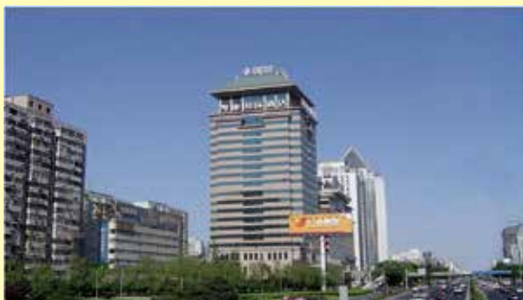
工程名称: 凯康国际酒店 工程地点: 北三环安慧桥北 建设单位: 凯康房地产公司 总包单位: 建工二建 防水范围: 卫生间、桑拿间、游泳池防水 防水面积: 1.3 万 \text{m}^2
