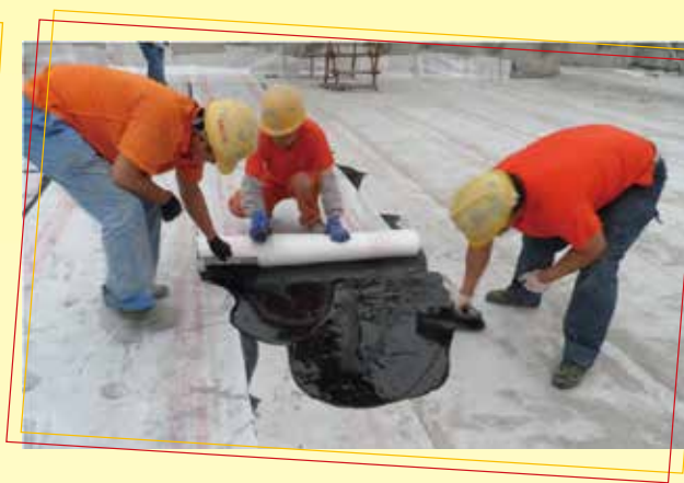
地铁 15 号线安立路站、大屯路站用非固化粘结聚乙烯丙纶卷材：喷涂与刮涂施工
