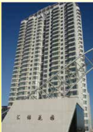
工程名称: 太原汇锦、 丽园工程 工程地点: 太原滨河西路 建设单位: 山西焦煤集团 总包单位: 山西建工 集团总公司 防水范围: 地下车库顶板种 植屋面防水, 地下车库防水 防水面积: 5.3 万 \text{m}^2
