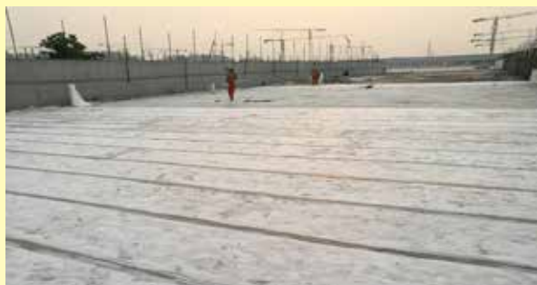
工程名称: 北京地铁 16 号线 28 标 工程地点: 北安河 建设单位: 快轨公司 总包单位: 中铁电气化局 防水范围: 运用库、检修库、咽喉区等 防水面积: 25 万 \text{m}^2
