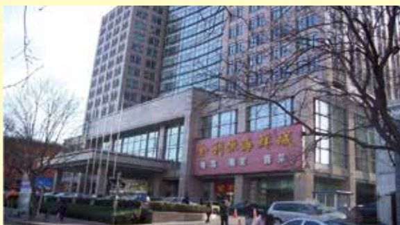
工程名称: 太平洋国际大厦 工程地点: 知春路 建设单位: 太平洋国际公司 总包单位: 清华工美装饰公司 防水范围: 游泳池、桑拿间、卫生间防水 防水面积: 0.55 万 \text{m}^2
