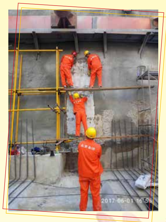
立墙防水施工
