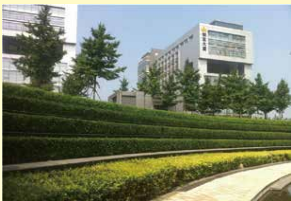
工程名称: 清华科技园 工程地点: 中关村东路 1 号 总包单位: 清华科技园建设股份公司 防水范围: 地下车库, 种植屋面 防水面积: 4.6 万 \text{m}^2
