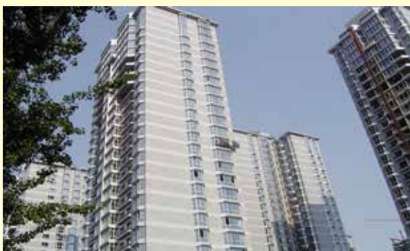
工程名称：通用时代国际中心 工程地点：建国门外大街 建设单位：北京通润集团 总包单位：中建公司 防水范围：1 ~ 5 # 楼高层厨卫间防水 防水面积：1.8 万 \text{m}^2
