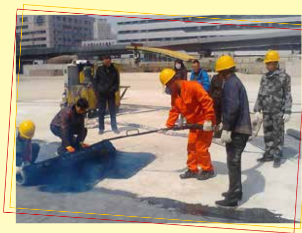
地铁 15 号线安立路站、大屯路站用非固化粘结聚乙烯丙纶卷材：喷涂与刮涂施工
