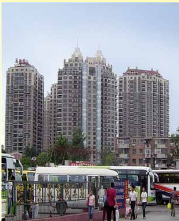
工程名称：当代万国城 工程地点：东直门外大街 建设单位：当代鸿运房地产开发公司 总包单位：建工七公司 防水范围：地下夹层、B4 区 J、K 座厨卫间防水 防水面积：5.55 万 \text{m}^2
