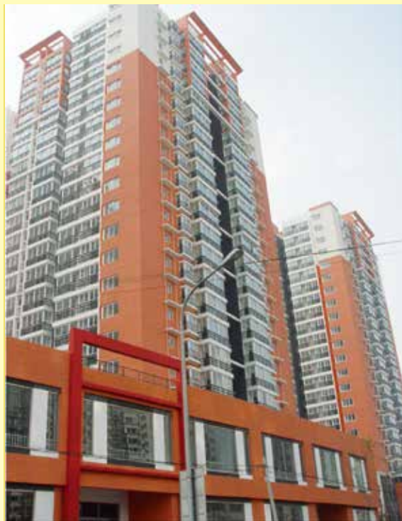
工程名称：民政家园 工程地点：岳各庄 建设单位：民政局 总包单位：住总六公司 防水范围：地下室防水 防水面积：3.5 万 \text{m}^2
