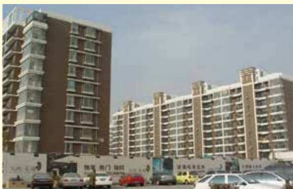
工程名称: 天鸿美域 工程地点: 丰台区小屯路 建设单位: 天鸿集团 总包单位: 江苏南通六公司 防水范围: B08--B14 # 楼厨卫间防水 防水面积: 15 万 \text{m}^2
