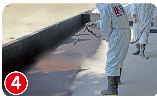
喷涂（涂刮）非固化（可专用设备预先加热）
