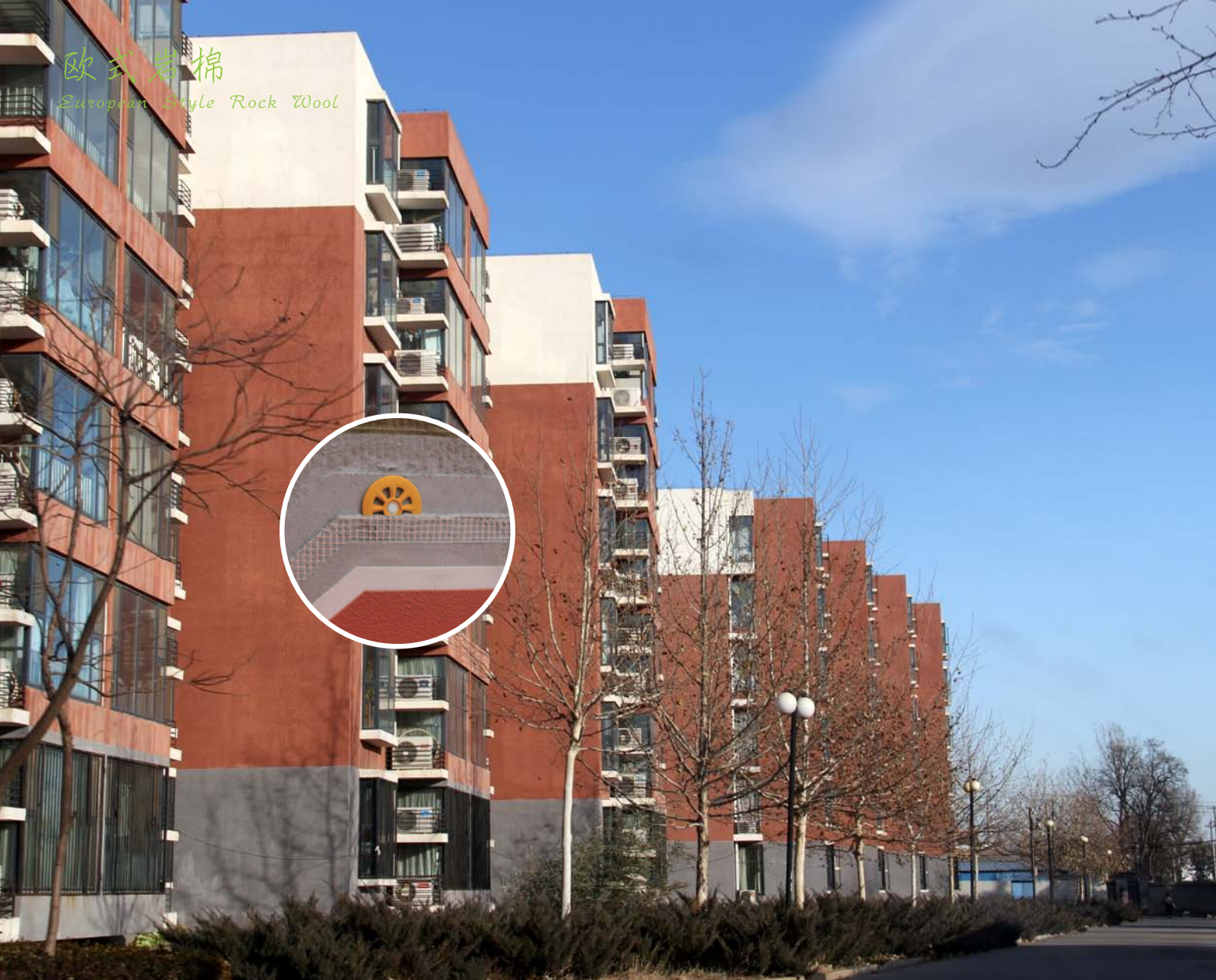
北京市老旧小区改造项目 一昌平南农家园
