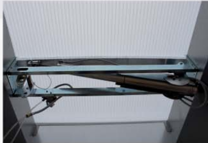
气动开启系统……仅使用一个气缸开启
