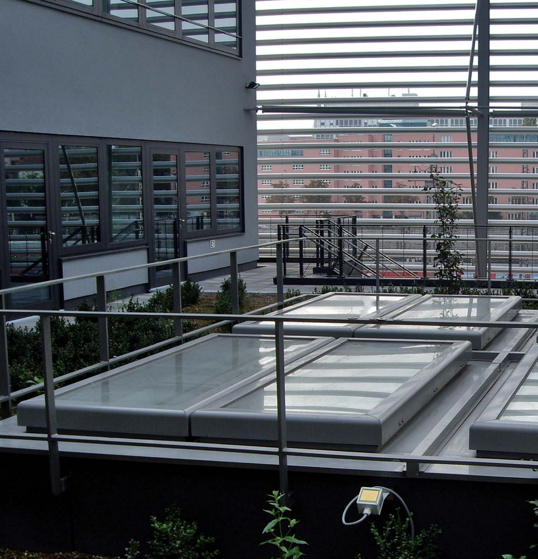
图示：安装在地面上的FIREFIGHTER 一字型自然散热通风系统。
