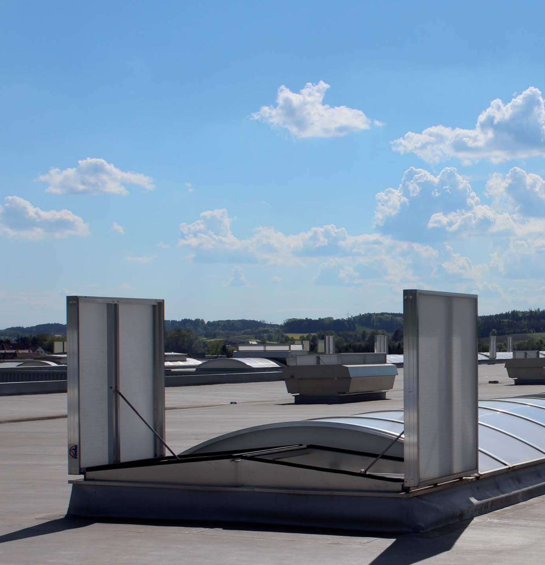
图示：PHOENIX系统自然散热排烟系统安装在EUROLIGHT天窗尾部。
