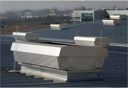
安装在梯形金属屋顶上
