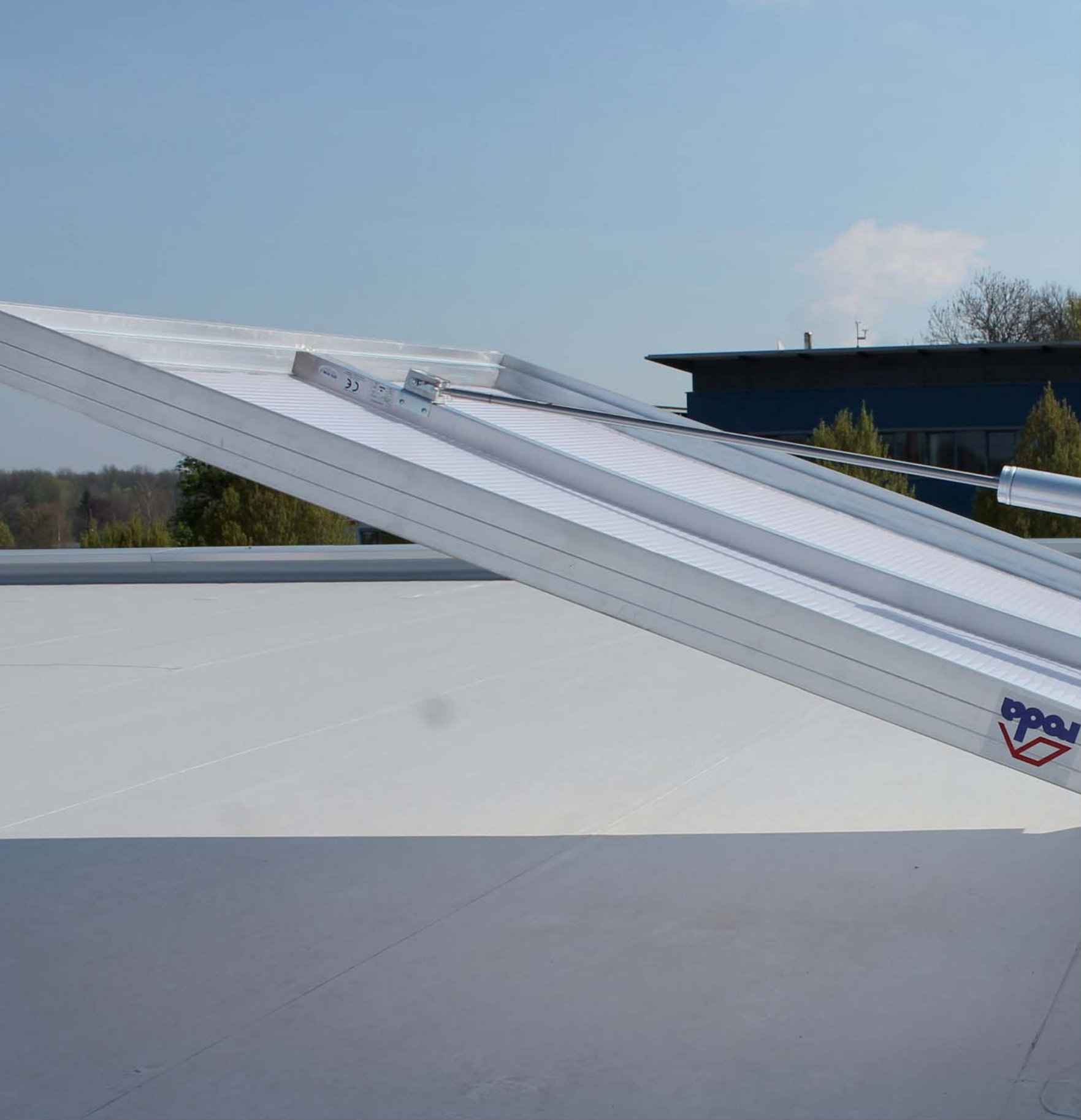
图示：安装在一家食品公司屋顶上呈打开状态的VenturiSmoke系统。
