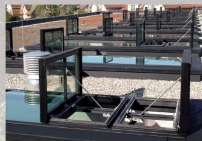
安装在玻璃天窗上
