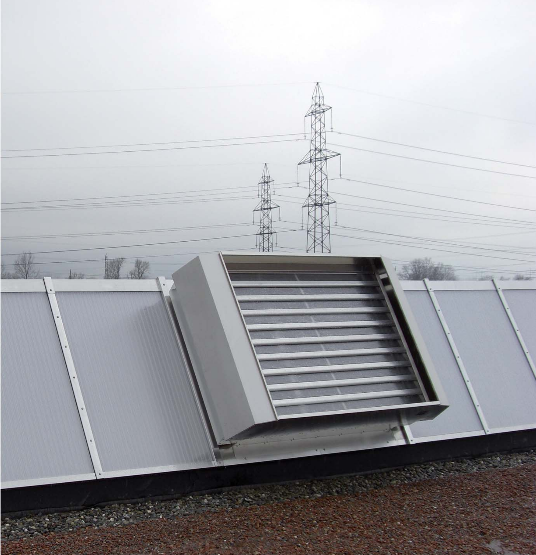
图示：配有阳光板百页窗片的MULTIJET装置安装在DELTALIGHT天窗系统上。
