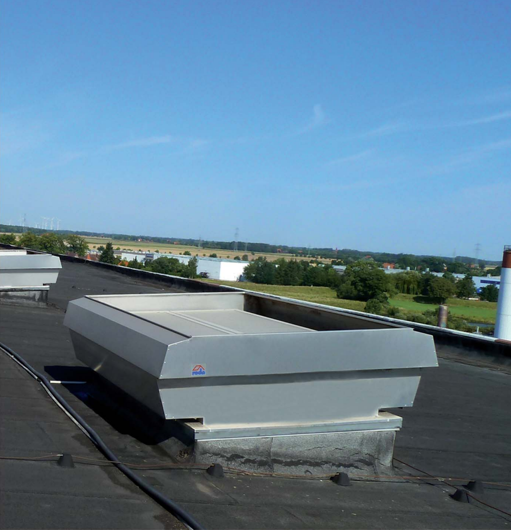
图示：安装在工厂建筑物顶的MEGASTAR自然排烟通风系统。
