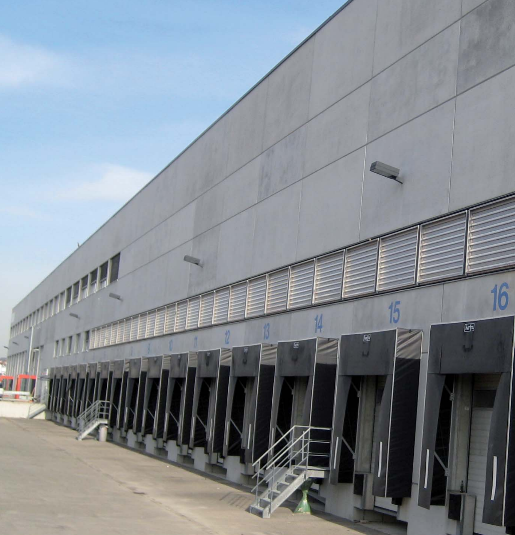
图示：作为送风单元，安装在墙体上的SMOKEJET。
