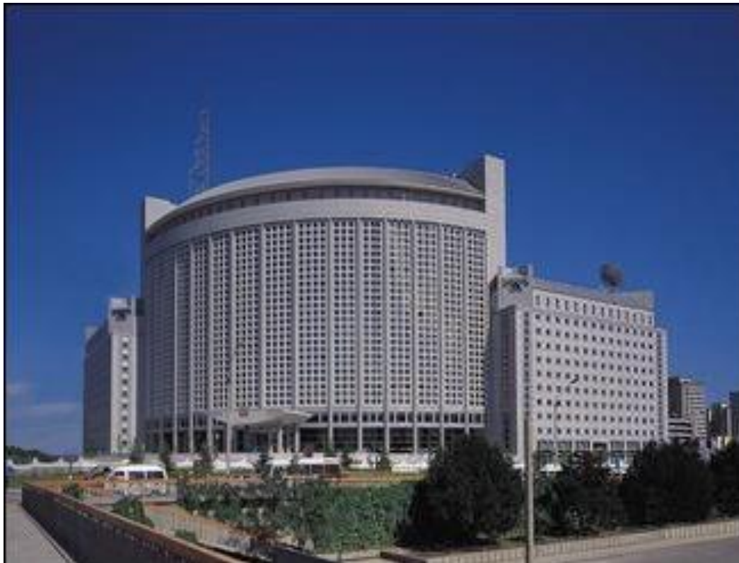
中国外交部幕墙改建项目
