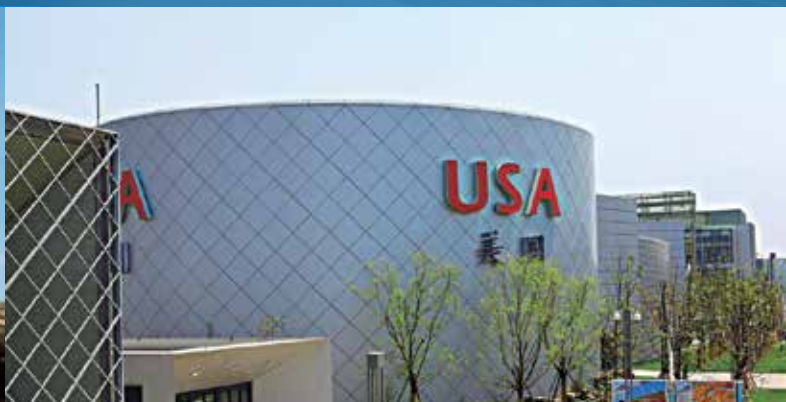
工程名称：2010上海世博会美国馆 US Pavilion, World Expo 2010 屋面面积/Roof area:4400m 2
