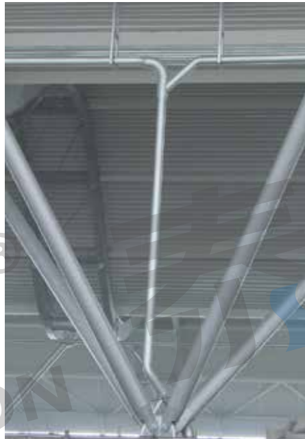
郑州新郑国际机场二期扩建工程
