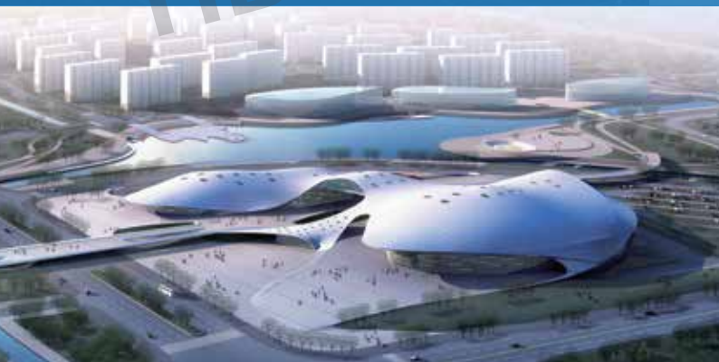
工程名称：广州亚运会综合体育馆 Integrated Gymnasium of Guangzhou Asian Games 屋面面积/Roof area : 33000m 2
