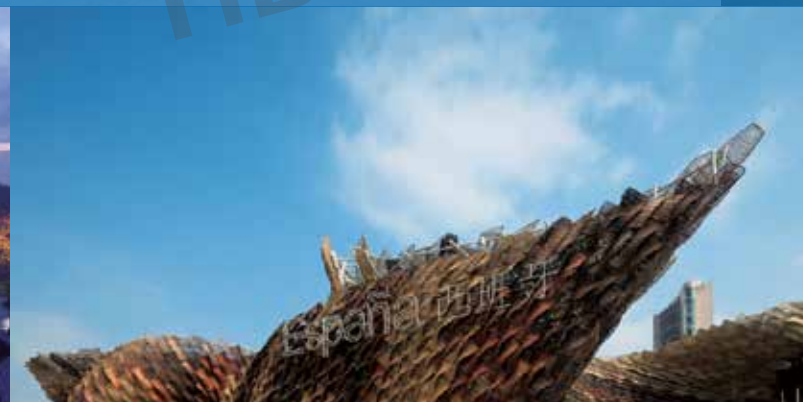
工程名称：2010上海世博会西班牙馆 Spain Pavilion, World Expo 2010 屋面面积/Roof area:4700m 2
