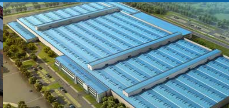
工程名称：北京奔驰发动机联合厂房 New Engine Plant of Beijing Benz 屋面面积/Roof area：37060m 2
