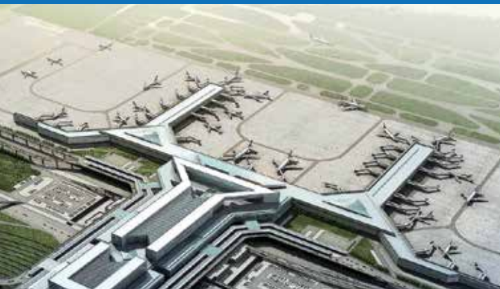
工程名称：上海虹桥机场2号航站楼 Shanghai Hongqiao Airport 屋面面积/Roof area:168500m 2
