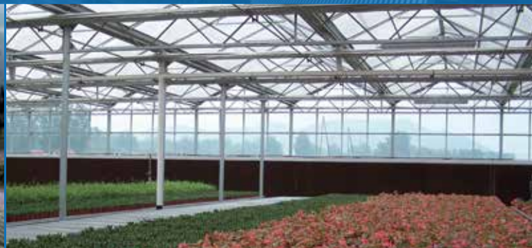
工程名称：北京欧阁有机农庄 Beijing Ouge Organic Farm Village 屋面面积/Roof area：3110m 2
