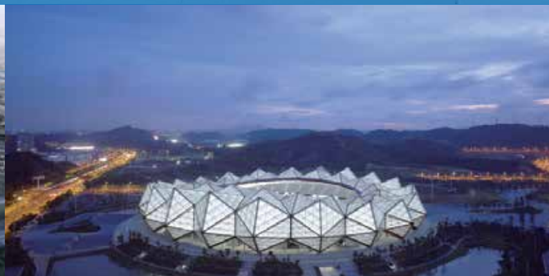
工程名称：深圳大学生运动会主体育场 Main Stadium of Shenzhen World University Games 屋面面积/Roof area : 39000m 2
