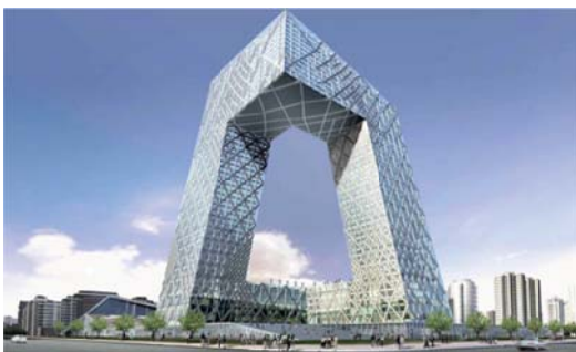
中央电视台新台址
