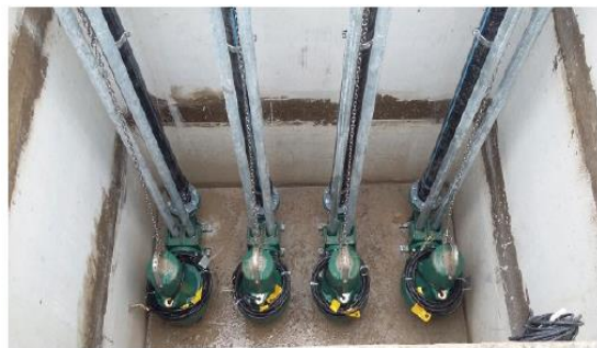
意大利汉堡王餐厅污水系统 SEWAGE SYSTEM OF 4 FKV 80 FOR THE BURGER KING (OBI ITALY)
