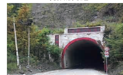
重庆三排山隧道
