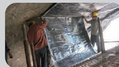
施工下幅卷材
