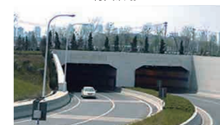
南京九华山隧道
