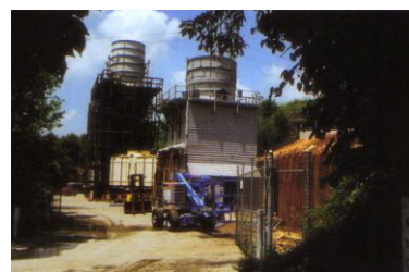
研发中心实塔测试场
