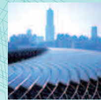
2009台湾高雄世界运动会主场馆 落成时间：2009年 设施用途：公共设施
