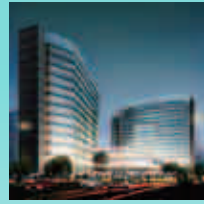
上海世和中心 落成时间：2011年 设施用途：办公大楼
