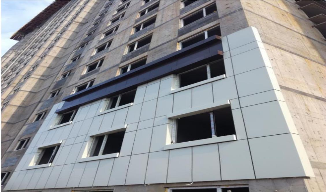
（五）防水防潮。保温装饰一体化版优良的自身结构及板材间紧凑的凹凸插接扣槽式的安装方式，避免了雨、雪、冻、融、干、湿，循环造成的结构破坏，安装后消除了墙面渗水之忧，有效地避免了室内墙面发霉的现象。即使是在严寒地区也可达到无渗水变形的效果，延长建筑使用寿命。
