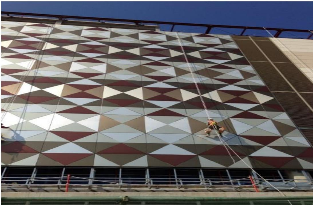
（四）施工周期短，安装便捷节省成本。保温装饰一体化板采用的安装系统方式简单快捷，可以降低龙骨系统费用，并不受季节气候和地理环境限制，可以显著缩短工程周期，节约兼职成本，降低综合造价。同一项目施工工期比石材幕墙施工工期缩短 35%以上，比传统薄抹灰系统施工工期缩短 50%以上，节省了时间、人工、管理成本。施工影响及安全隐患减少尤其适用既有建筑改造，可有效地将用户工作、生活的影响降至最低
